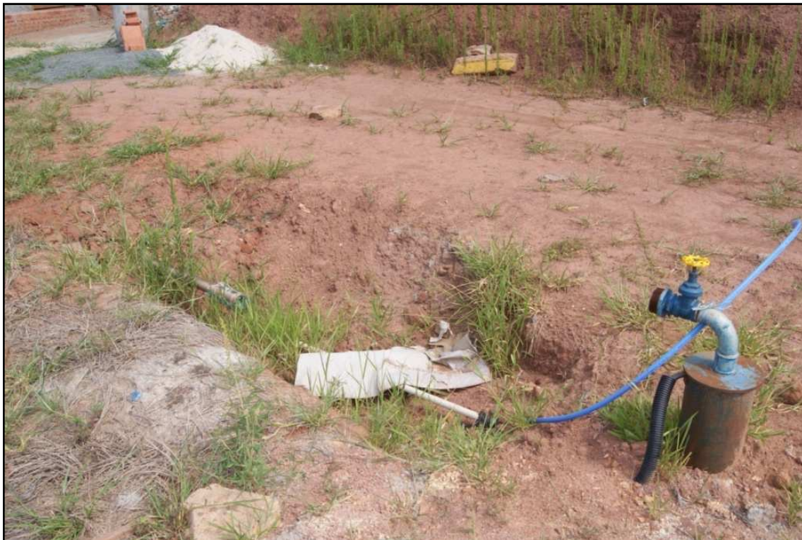
Foto 3: Poço Campo 2 (em construção). Fonte: Maximus Environmental.
